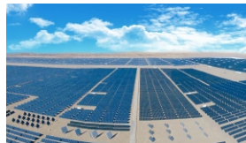
光伏电站工程
